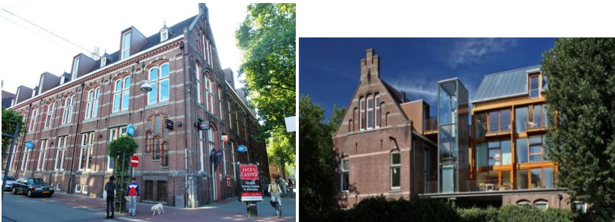
Figuur 13&14. Oude postkantoor Nijmegen na transformatie. (Bron: Kennis- en projectenbank Herbestemming, n.d.)
