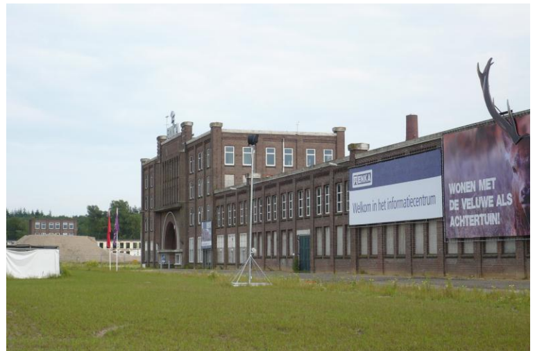
Figuur 43: Poortgebouw (eigen foto)
