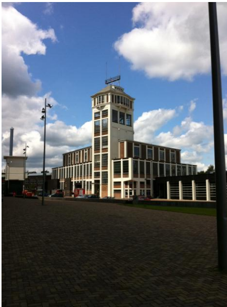
Figuur 31: Brandweerkazerne in Hengelo, thans gerealiseerd in bestaand vastgoed. (eigen foto)
