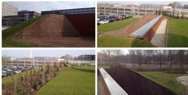
Fragment 57 – Ziekenhuis Aanleg daktuin en terreininrichting Spinosacentrum
