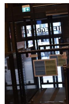
Figuur 14 De lift bij de ingang.
