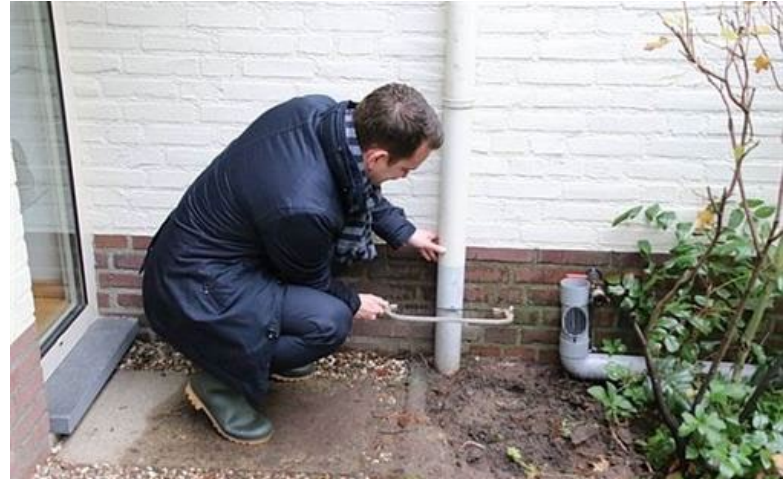
Figure 12: Disconnection from the sewage in Weert, Heerlijk Weert (n.d.)
