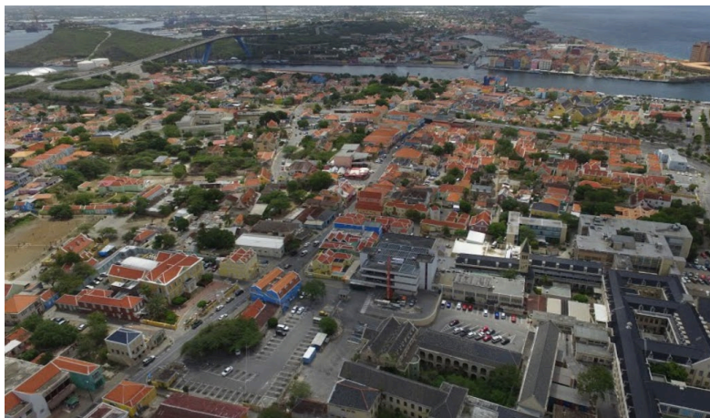
Figure 3.12 – Aerial view of Otrobanda (“Punda en Otrobanda”, n.d.)
